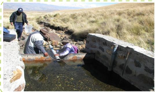
Como por ejemplo para determinar el caudal del CANAL CHONTA se determino con el área transversal resultando  $0.12 \text{ m}^3/\text{s} = 120\text{L/s}$  Este dato es muy importante para calcular las dimensiones tanto de los sedimentadores como de las celdas del humedal.
